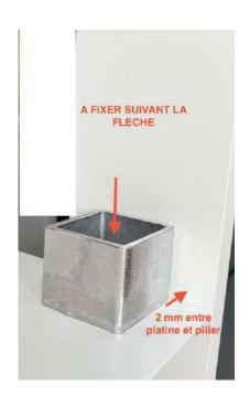
Fixer la platine invisible sur le mure à 2 m du pilier (espace nécessaire pour placer le pilier 85/85m sur la platine)
